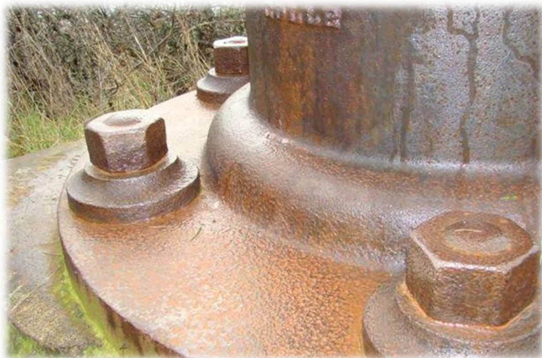
Il fissaggio al basamento è assicurato da 6 bulloni, disposti sulla flangia a 60° l'uno dall'altro; il dado misura mm. 85.
