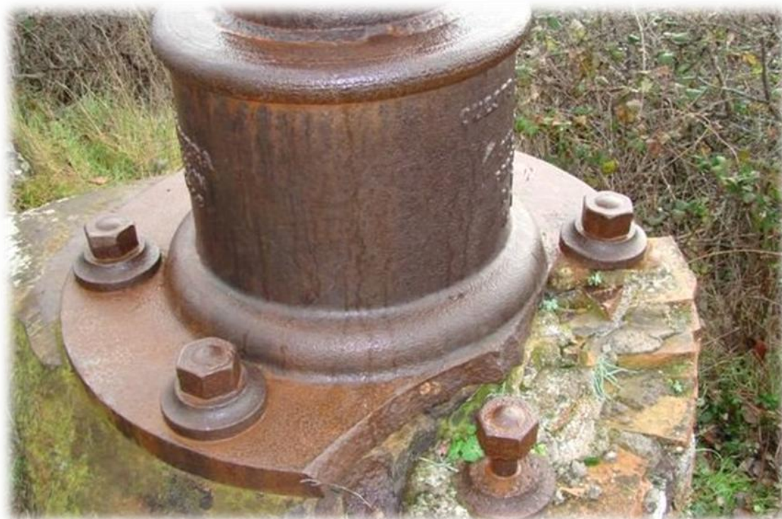
La base di fissaggio della Croce.
